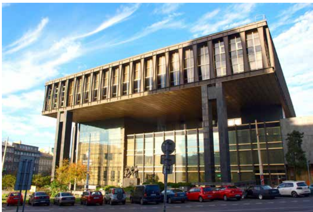
Bývalá budova Federálního shromáždění. Foto: VitVit, Wikimedia Commons
